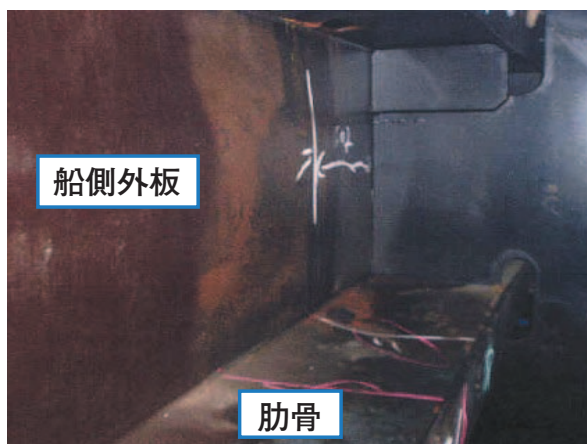
図8 船側外板及び縦通肋骨の変形
