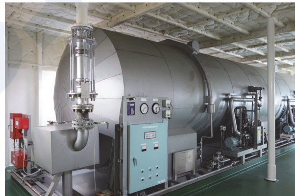
図5 船舶用CO2消火装置（-17℃・2.1MPa）
