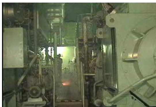
発電機の間における模擬火災
