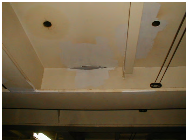
写真 1. トランスウェブのタック隅肉溶接部の破断及び板／ウェブの座屈
