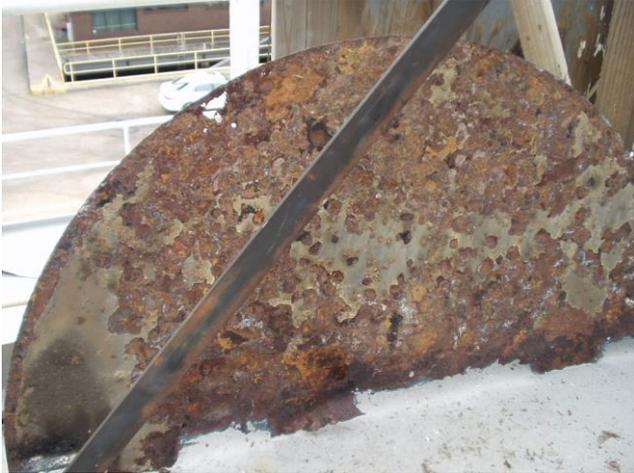
衰耗により破孔した防火ダンパーフラップ
