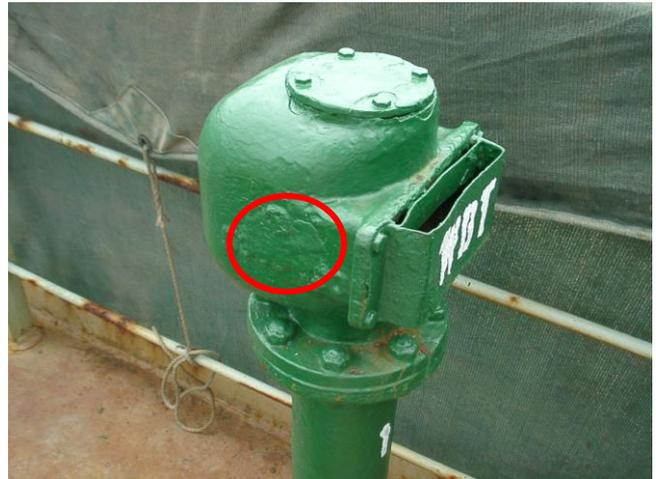
破孔個所のパテ（デブコン）による不適切な補修
