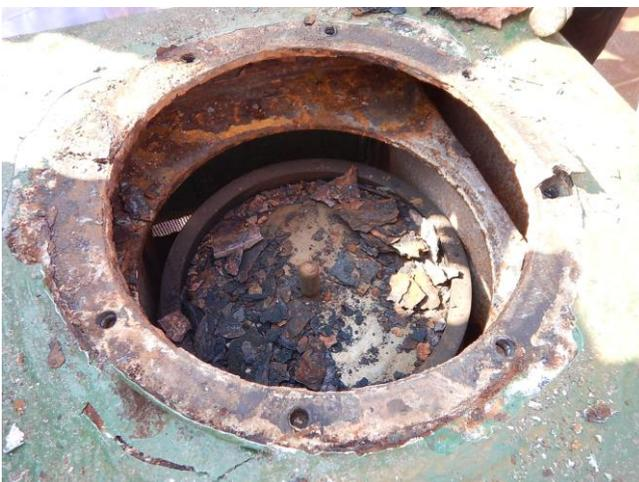
腐食衰耗した空気管頭内部
