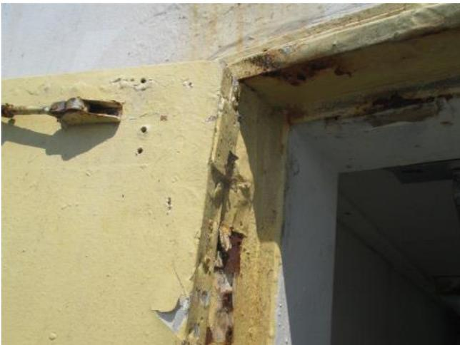
腐食衰耗したドア及びドアフレーム
