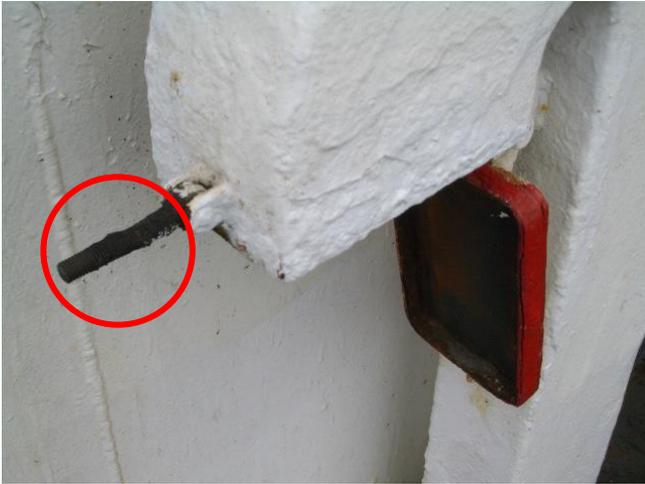
閉鎖装置固定用バタフライナットの欠落
