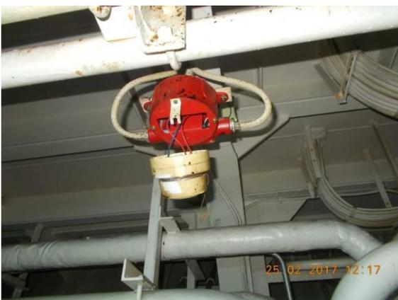
損傷した火災探知器
