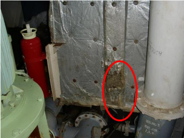
著しく損傷した A-60 防火材
