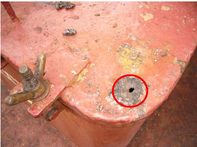
腐食衰耗により破孔した小倉口蓋
