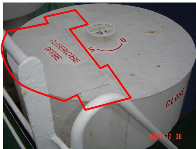
破孔個所のテープによる不適切な捕修
