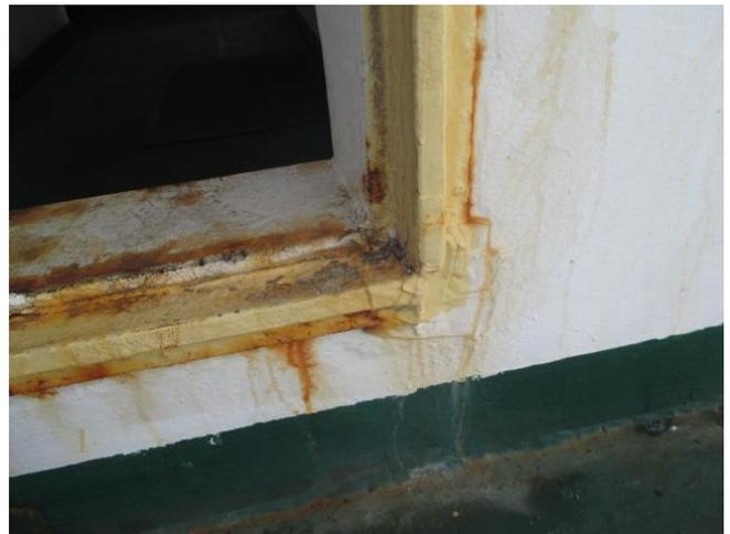
腐食衰耗したドアフレーム
