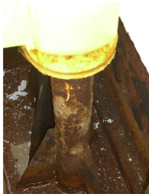
腐食衰耗した空気管
