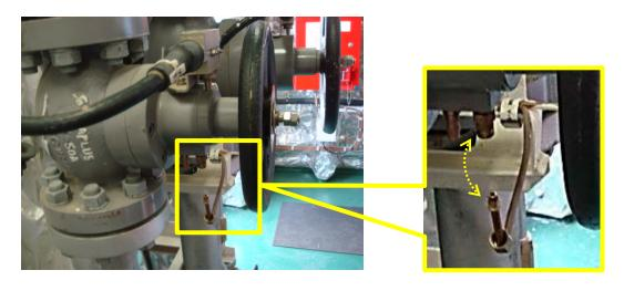
(1) CO2 discharge valve 操作 Pilot line の復旧忘れの例
