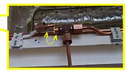
(2) CO2 シリンダー操作 Pilot line の復旧忘れの例
