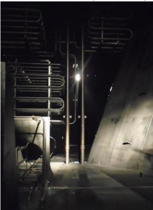
3. タンク側壁とヒーティングコイル (タンク上部より撮影)
