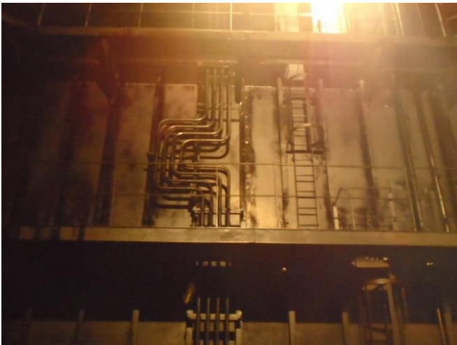
1. タンク側壁 (タンク底部より撮影)
