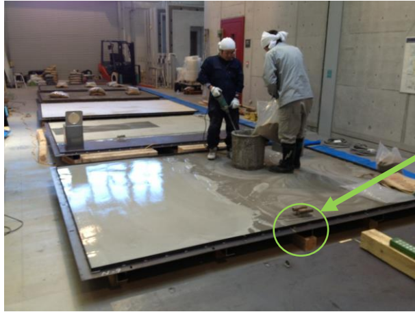
試験体 床材施工状況
