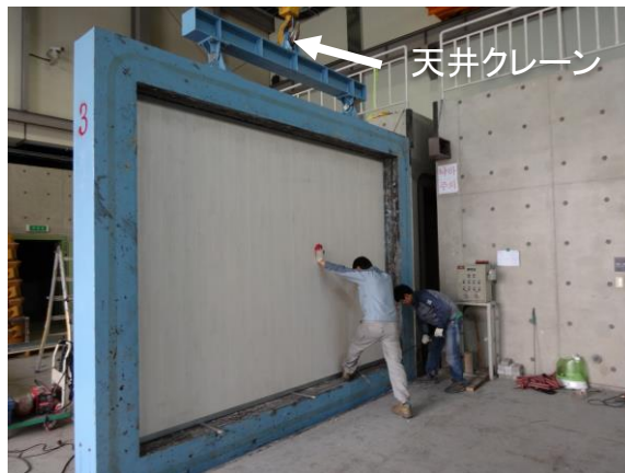
試験体 パネル施工状況
