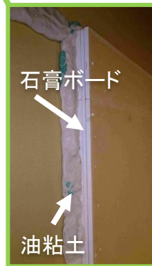
扉穴塞ぎ部拡大写真
