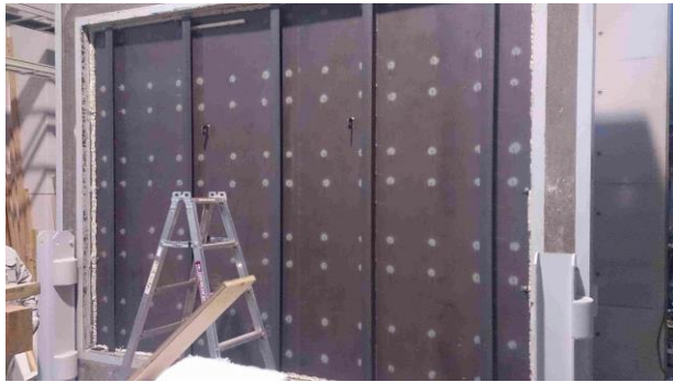
試験体 防熱ピン施工状況
