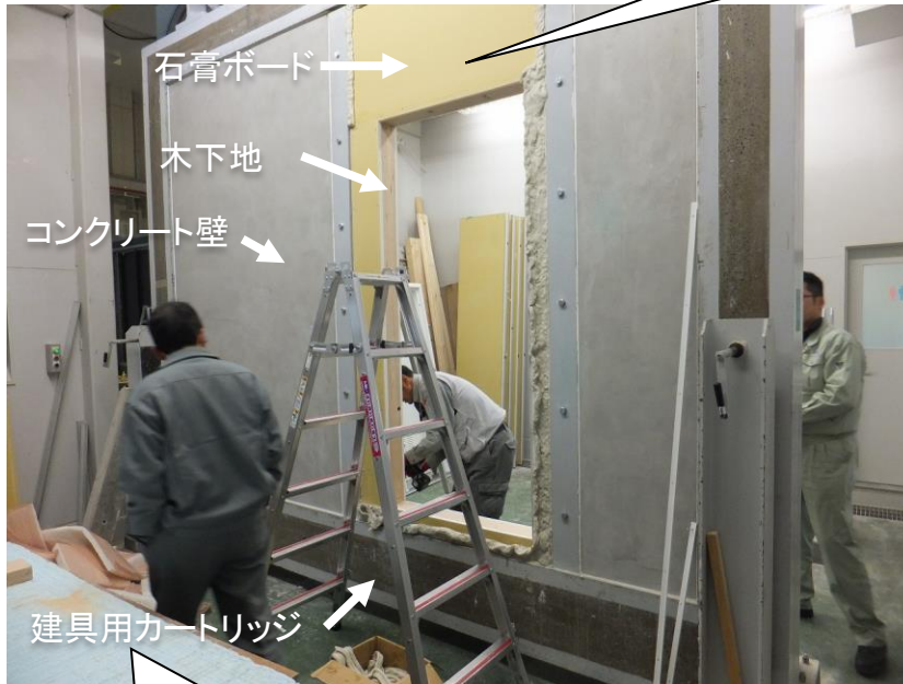
試験体 扉単体 施工状況
