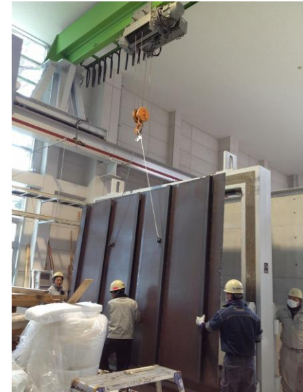
試験体 カートリッジへの取付け
