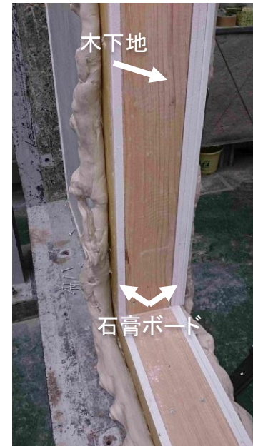
完成した仮想壁内面
