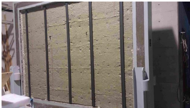
試験体 ロックウール施工状況
