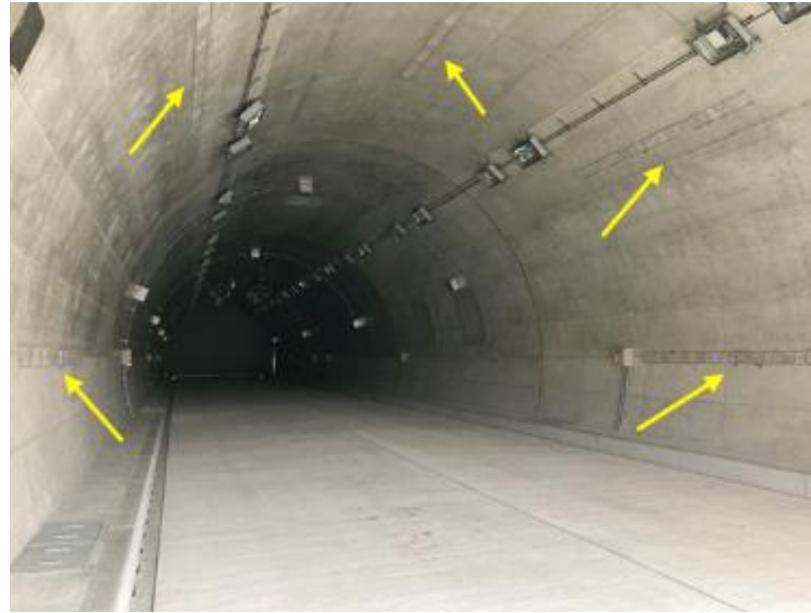
図1 福島 RTF 内試験用トンネル概観
