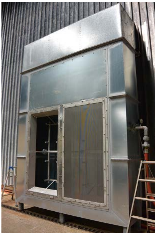
図 3.2.4 矩形ダクトへの発泡器の設置例(左:発泡ネット取付け前、右:発泡ネットあり)
