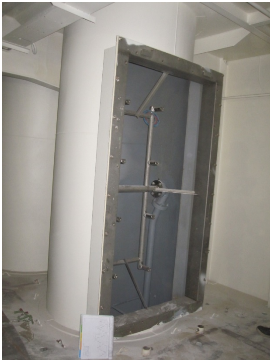
図 3.2.3 丸ダクトへの発泡器の設置例(発泡ネット取付け前)
