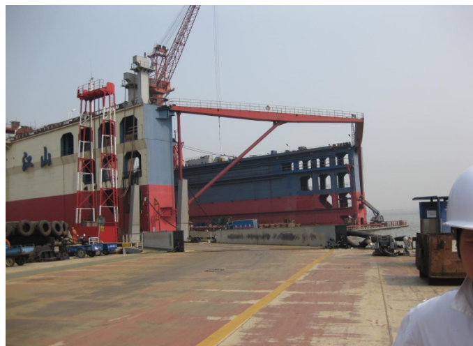
ドック(最終解体用に使用)
