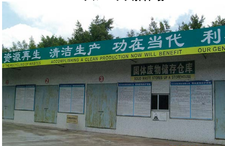
固体废物保存倉庫
