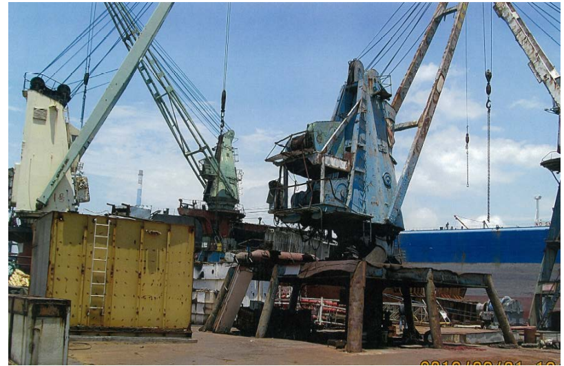
大ブロック解体場
