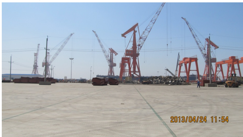
広大な二次解体場
