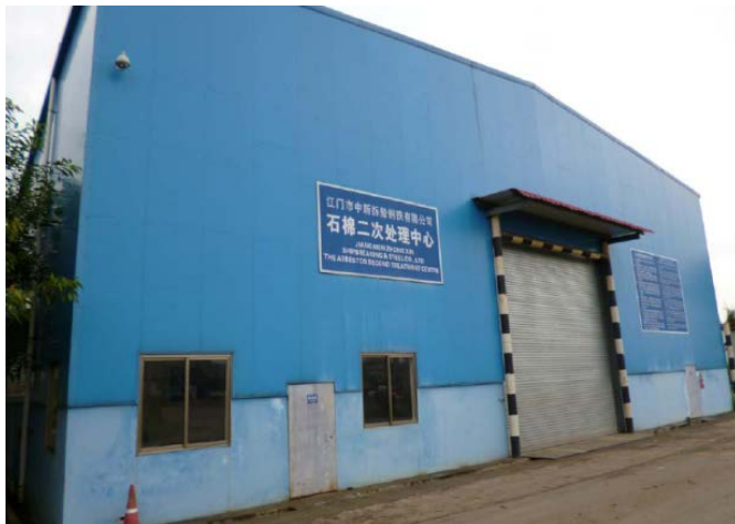
アスベスト処理建屋
