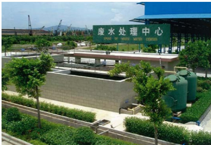
排水処理センター
