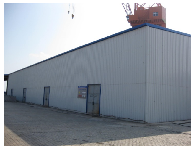
危険物倉庫(含むアスベスト)
