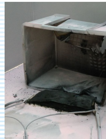
過電圧試験で焼損したセル
