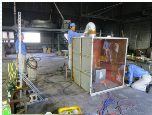
消火器メーカー初田製作所の 試験施設にて実施
