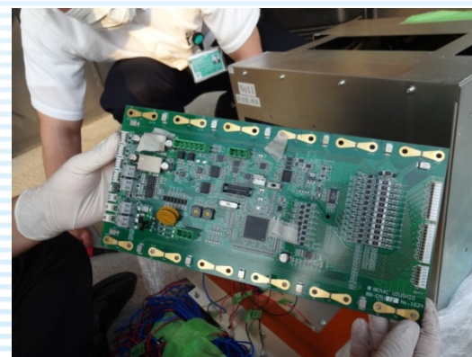
CMU基板には異常なし
