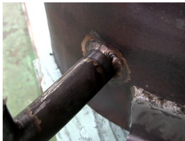
受信映像(パイプ継手部)
