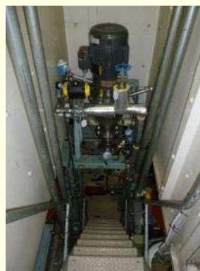
タービン-発電機
