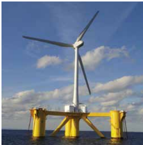
FUKUSHIMA MIRAI Unidad de Turbina de Viento Offshore construida por Mitsui Engineering & Shipbuilding Co., Ltd. Chiba Shipyard
