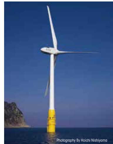
HAENKAZE Unidad de Turbina de Viento Offshore construida por Toda Corporation
