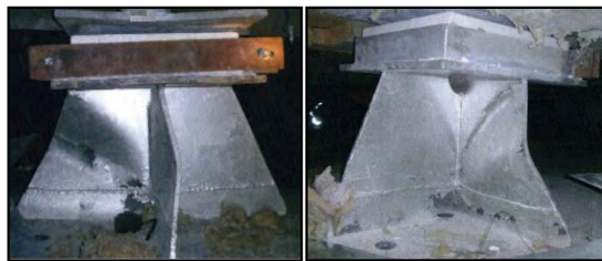
独立型方形タンクの支持構造
