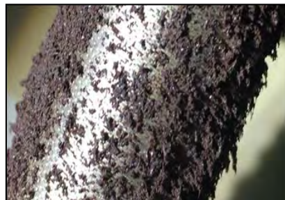
フィルターに詰まったスラッジ
