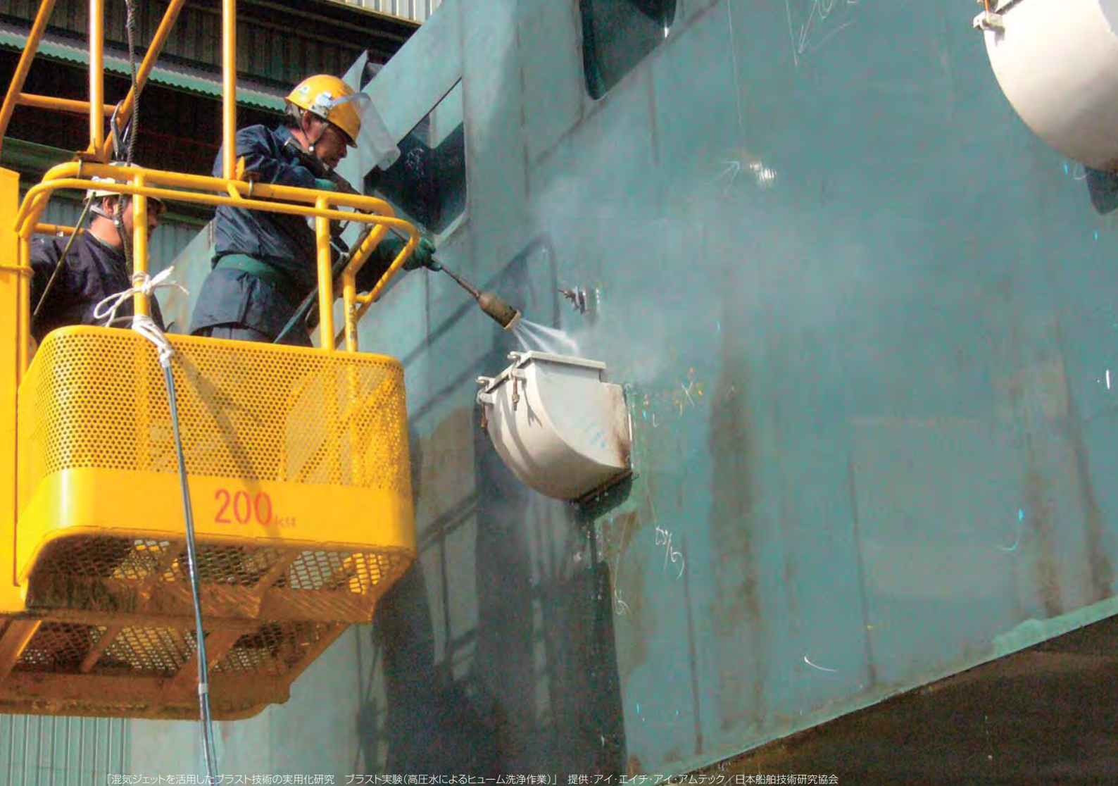
「混気ジェットを活用したプラスト技術の実用化研究 プラスト実験(高圧水によるヒューム洗浄作業)」 提供:アイ・エイチ・アイ・アムテック/日本船舶技術研究協会
