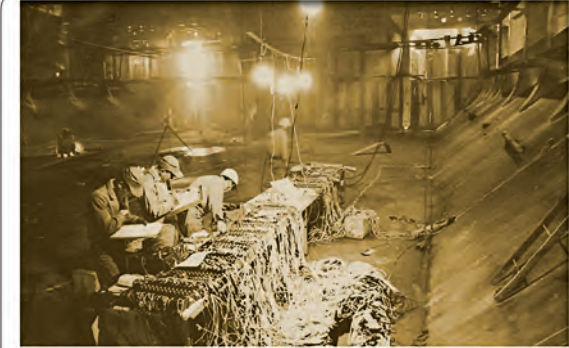
1964年对货轮双底构造全面测量
