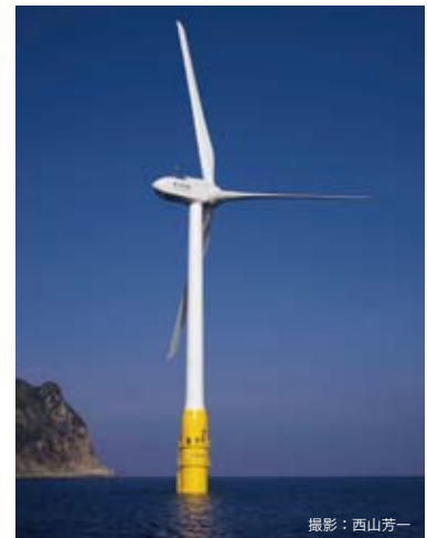
はえんかぜ 浮体式洋上風力発電 戸田建設建造
