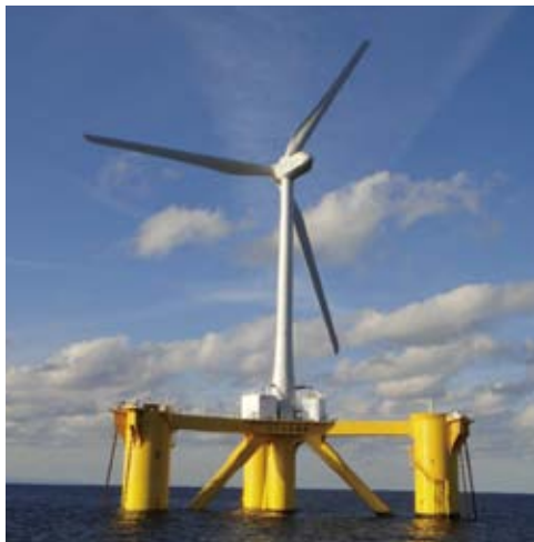
ふくしま未来 浮体式洋上風力発電 三井造船株式会社千葉事業所建造
