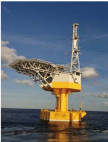
ふくしま絆 浮体式洋上サブステーション ジャパンマリンユナイテッド株式会社 横浜事業所磯子工場建造
